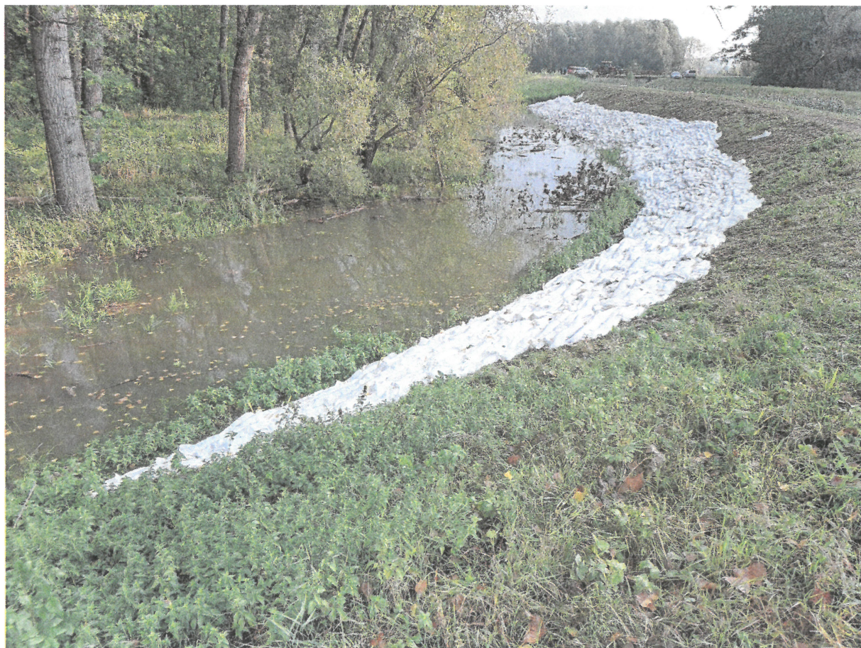
Průsaky hrázemi Litobratřického potoka, Drnholec - celkový pohled
