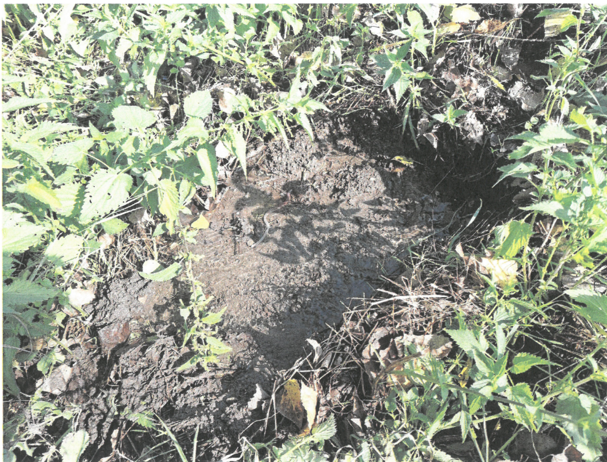
Průsaky hrázemi Litobratřického potoka, Drnholec – detail průsakové cesty
